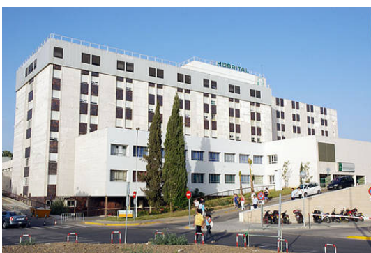
Edificio de Hospitalización del H.U. Reina Sofía de Córdoba
